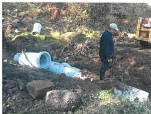
Figura 3 – Construção e ou Reposição de passagens hidráulicas na rede viária florestal.
