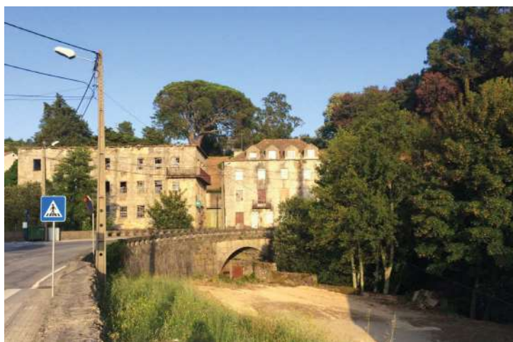
EDIFÍCIOS DA MATA DO DIQUE ▲
